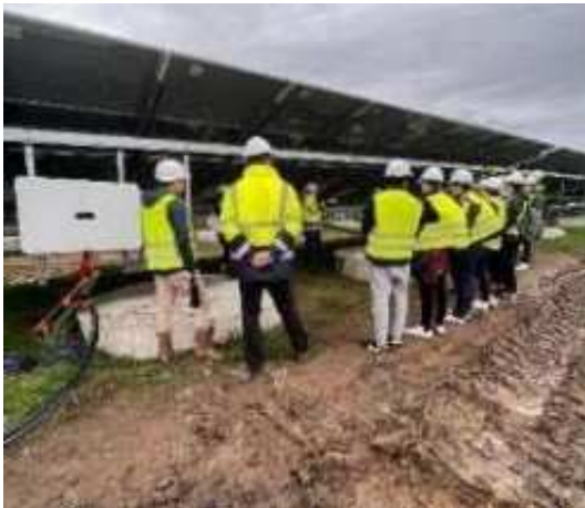
Organisation de visites de chantier
